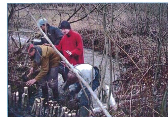
Фотографии 2007 года. Строительство плотин
